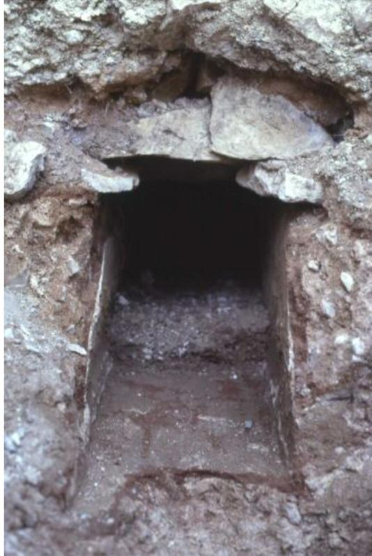
**Fig. 4 – Conduit du petit aqueduc souterrain de Villedieu-sur-Indre (Indre)**
